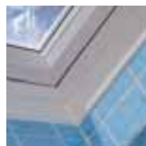
Die vorhandenen Fliesen bleiben erhalten.
