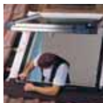
... und neues Fenster einsetzen.
