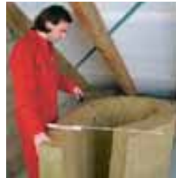
Folienverpackung aufreißen, lichten Abstand zwischen den Sparren ausmessen und Dämmstoff in der ermittelten Breite + ca. 1 cm Übermaß abschneiden
