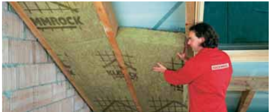
Klemmrock einfach zwischen die Sparren klemmen
