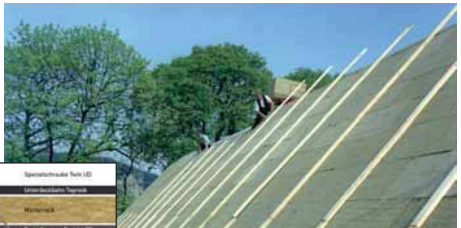
Klemmrock einfach zwischen die Sparren klemmen
