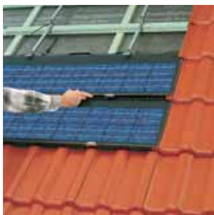
Die Module des Braas Solarstrom-Systems werden zusammen mit den Dachpfannen verlegt und fügen sich daher harmonisch in die Dachfläche ein.
