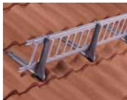
Beispiel Schneefang-Gitterhalterung auf einer Tonpfannendacheindeckung.
