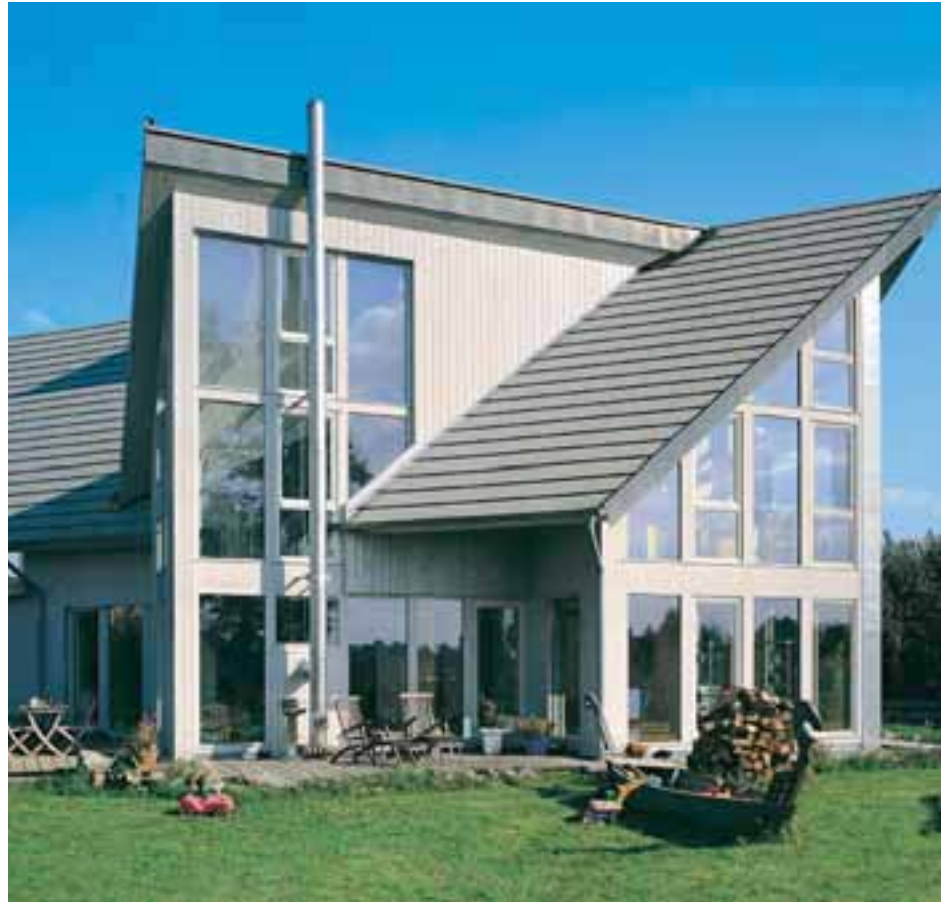
Architektenhaus, gedeckt mit Schmutz abweisendem Tegalit Seidenmatt (Star) in Hellgrau.
