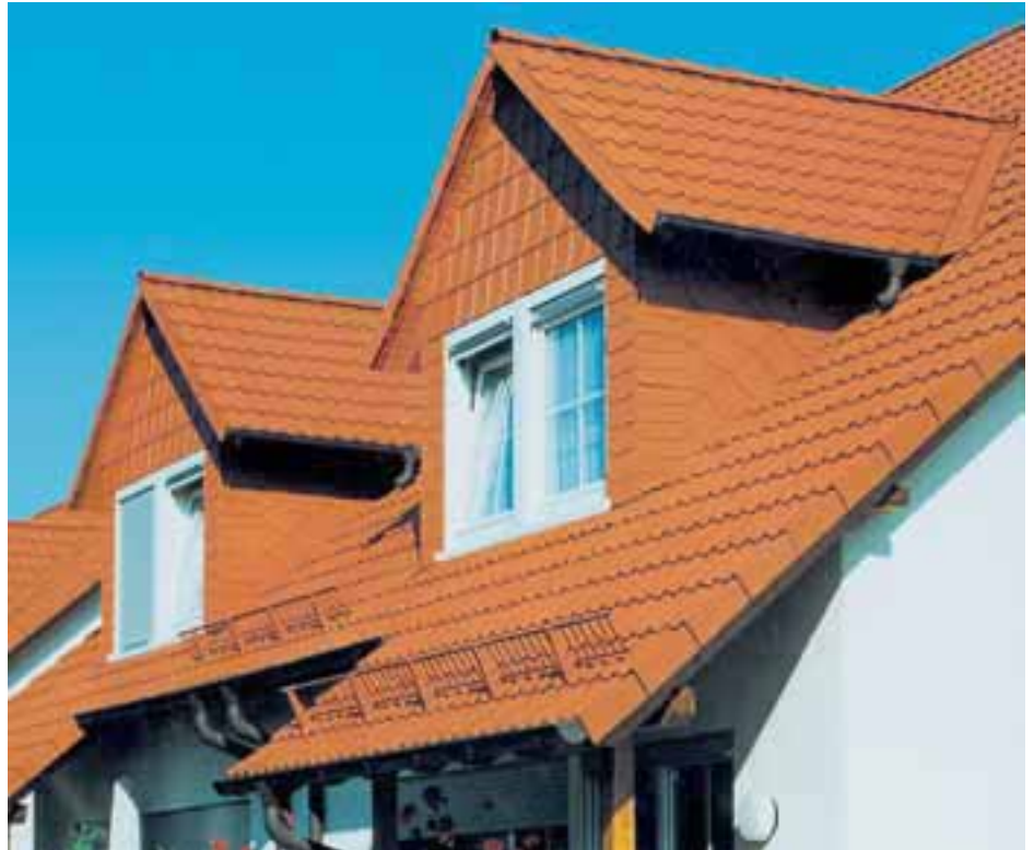
Das Dach ist mit Frankfurter Pfanne gedeckt, die Gaubenwände sind mit Braas Dekorplatte bekleidet, das Schneefanggitter schützt vor Dachlawinen.
