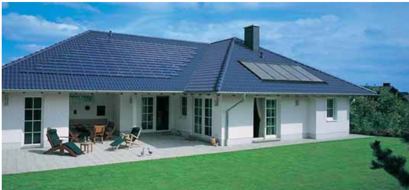
Braas Thermokollektoren und Solarstrom-Module passen sich harmonisch in die Dachfläche ein und bilden zusammen mit dieser eine wetterfeste Einheit.
