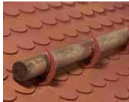
Beispiel Schneefang-Rundholzhalterung auf einer Biberschwanzdacheindeckung.
