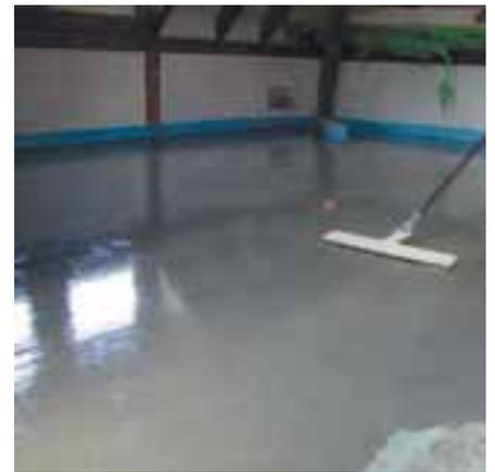
Neuer Bodenaufbau mit maxit plan ABS
