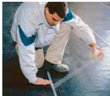
Damit lassen sich alte und schadhafte Oberflächen dauerhaft sanieren. Falls Feuchtigkeit aus dem Untergrund zu erwarten ist, sorgt die streichfähige FE-Abdichtung für wirksamen Schutz von unten.
