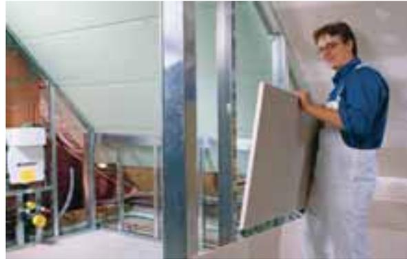
Durch die abgeflachte Fasekante ist die Knauf Paneelplatte die ideale Bauplatte für den gesamten Dachausbau.
